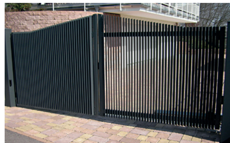
METALL-LAMELLEN 45 ° GEDREHT ANGEORDNET, TOROBERKANTE MITTIG SPITZ ZULAUFEND
