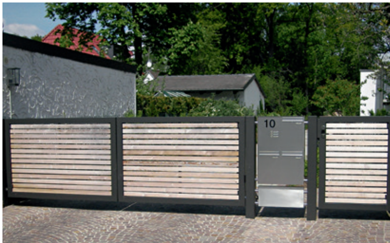
LÄRCHE-RHOMBUS-SCHALUNG IN DEN RAHMEN EINGESETZT
